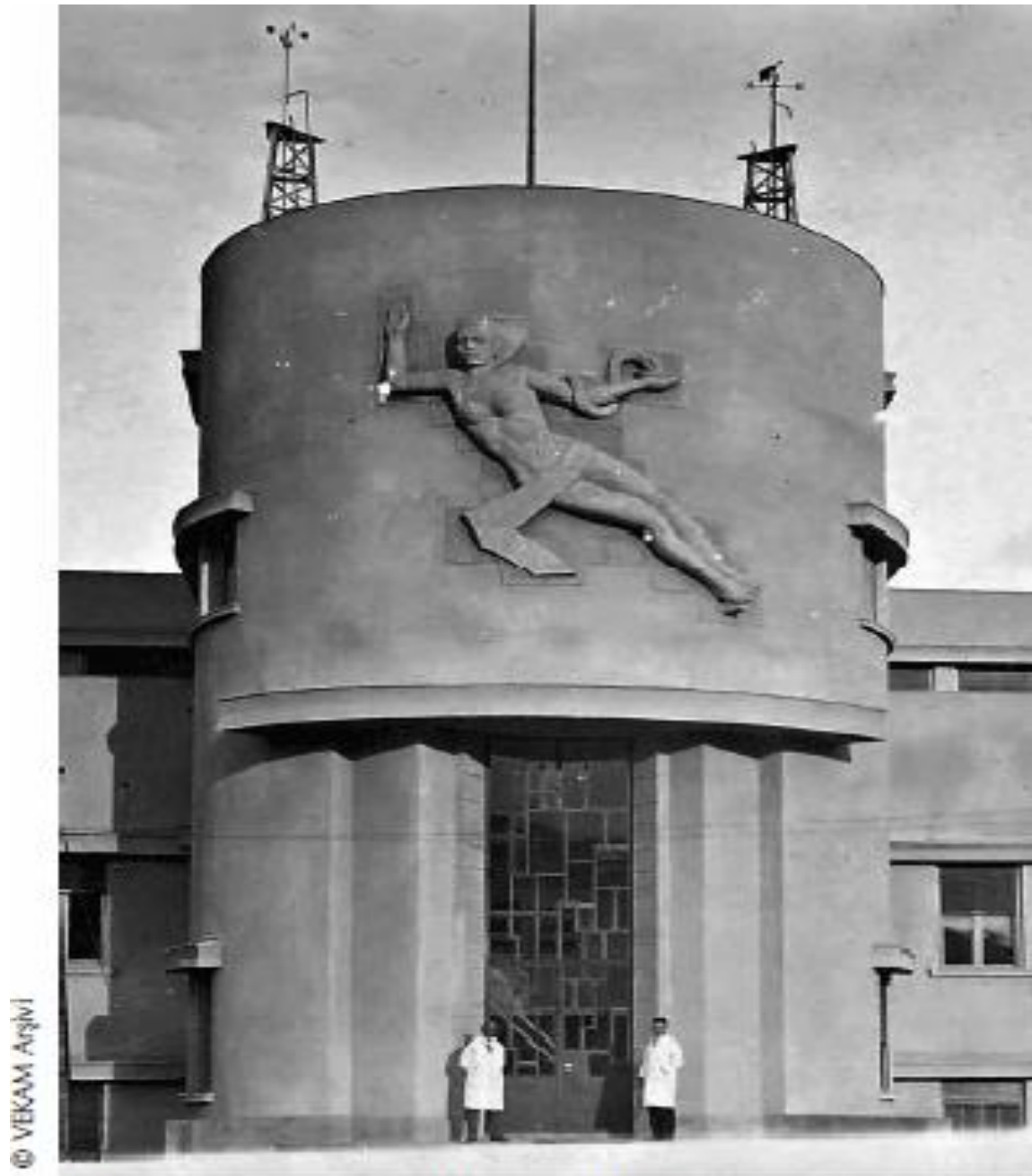
10. Kimyâhane ve Bakteriyoloji Binası, 1927
